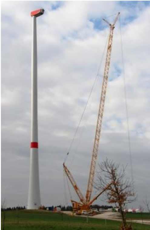
Eine der beiden Windkraftanlagen, die in der Nähe von Hüll errichtet werden. Die Gesamtkosten belaufen sich auf 9,5 Millionen Euro.
